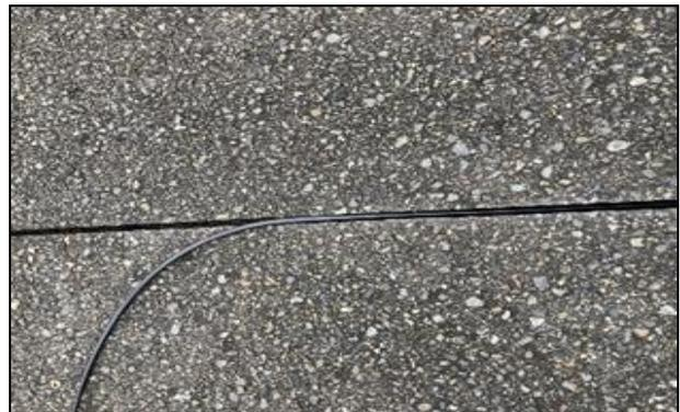
図-2 電磁誘導線
