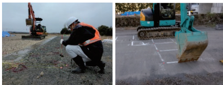
MG3機種での精度検証実施状況
