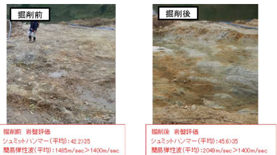
写真-4 油圧クサビ削岩 掘削前後
