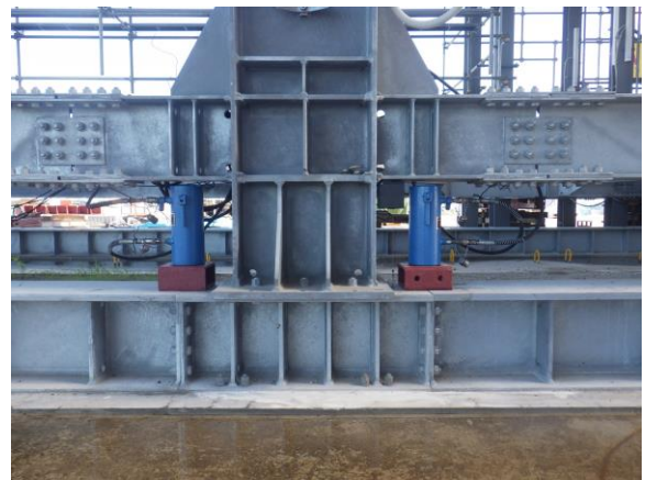
図-9 ジャッキアップ状況写真
