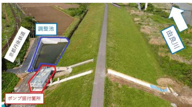
写真-4 現場実証試験箇所
