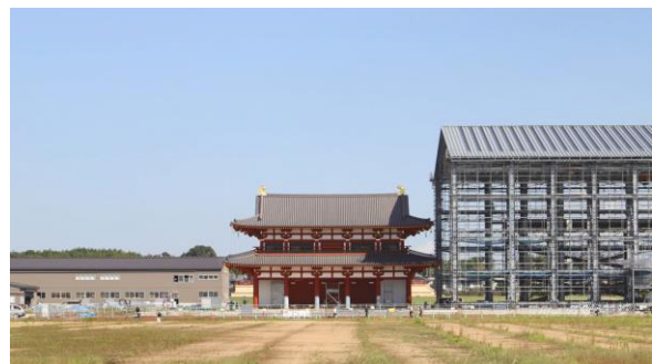
図-17 素屋根スライド完了
