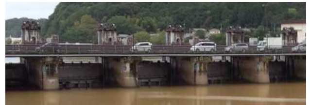
写真-1 瀬田川洗堰の全閉操作 (平成 25 年 9 月 16 日)
