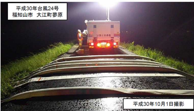
写真-3 2018年(平成30年)台風24号による内水被害への対応
