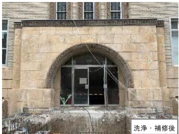
図-6 東側入口部分の補修前及び補修後
