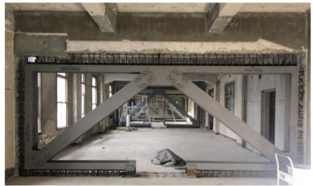
図-11 鉄骨ブレースの新設（3 箇所）
