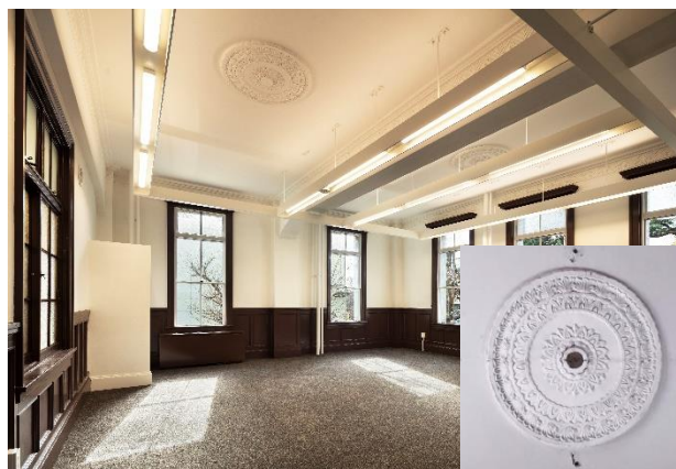
図-7 天井中心飾（左：補修・再設置後、右：補修前）
