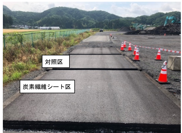
写真-3 試験施工箇所完成状況
