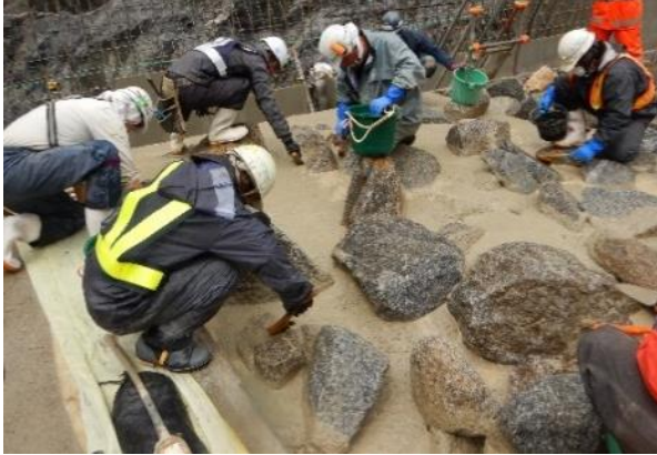
写真-6 新粗石コンクリート打設後の仕上げの様子
