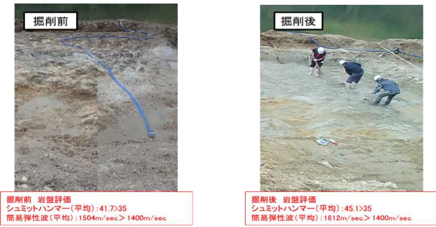
写真-6 大型ブレイカー工法 掘削前後
