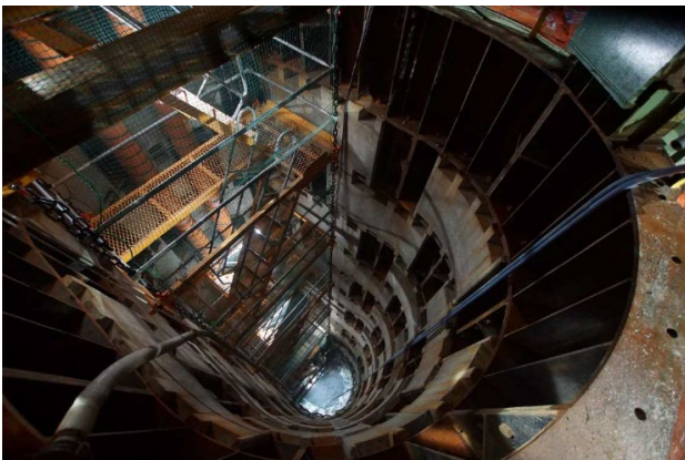
図-9 ドライアップが完了した状態
