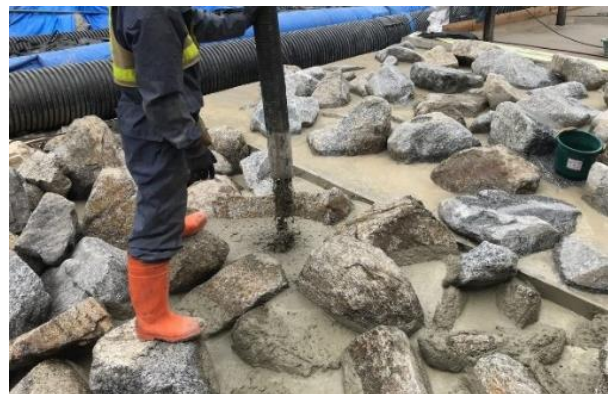
写真5 高流動コンクリート打設の様子
