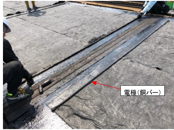
写真-2 電極(銅バー)の巻付け状況
