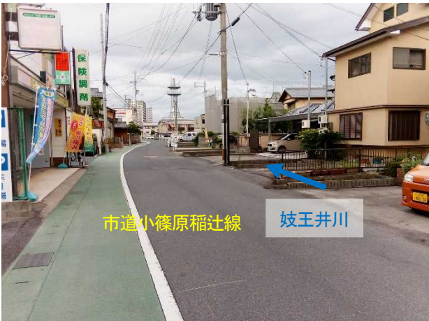
写真4 II期工事の現場状況
