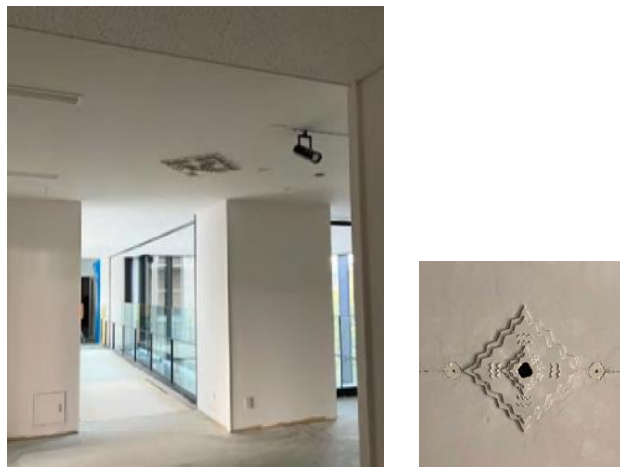
図-8 天井中心飾（左：補修・移設後、右：補修前）
