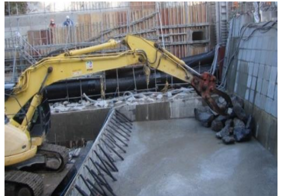
写真4 粗石敷設の様子
