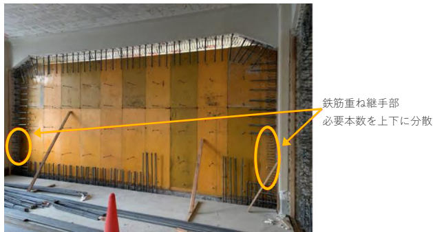
図-12 耐震補強部分のあと施工アンカー打設状況
