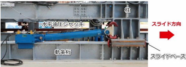
図-12 水平油圧ジャッキ取り付け
