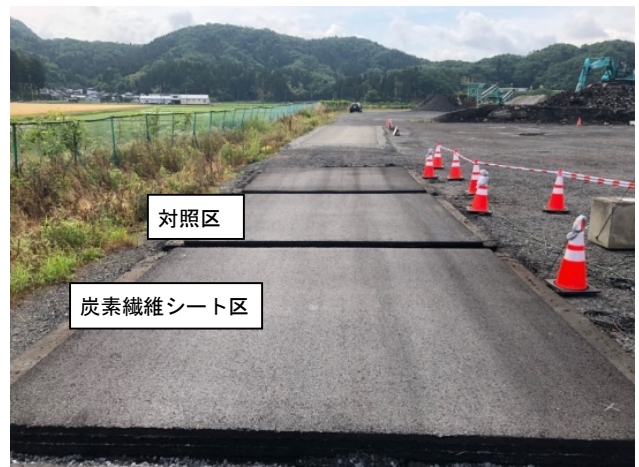
写真-3 試験施工箇所の完成状況
