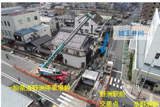
写真-2 Ⅰ期工事施工状況
