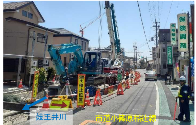
写真-10 施工状況
