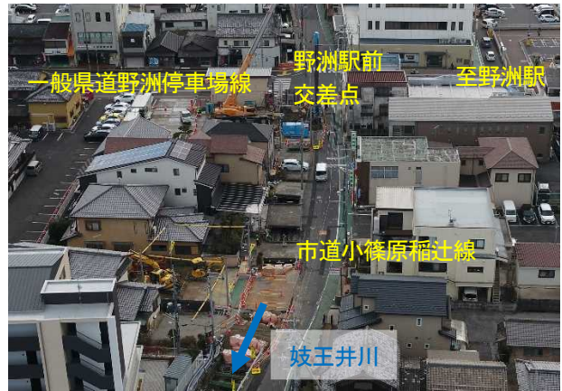
写真-3 Ⅱ期工事施工状況
