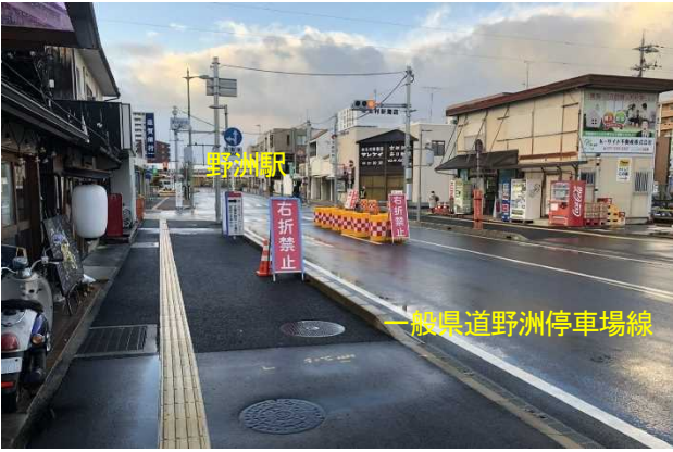
写真-9 クッションドラム設置状況
