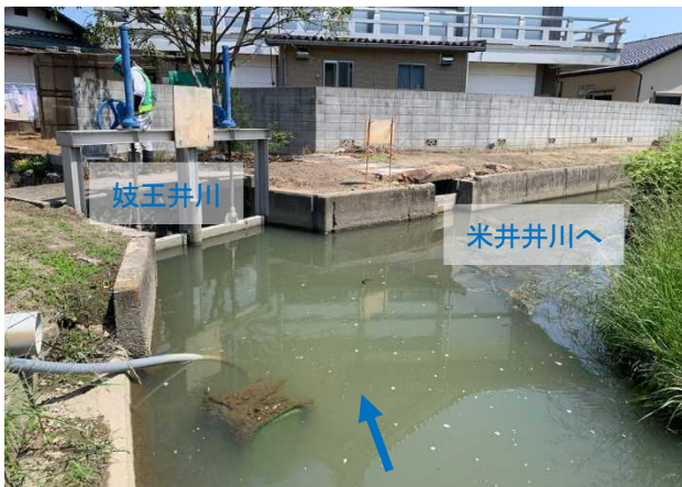
写真-6 小篠原水門
