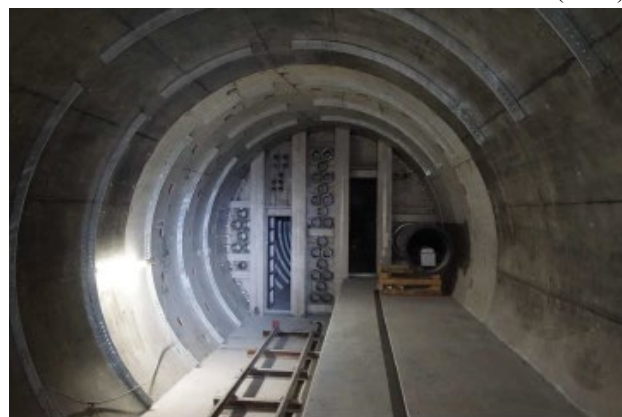
図-15 中間シャフト側地下防水扉（右に水道管Φ600mm）
