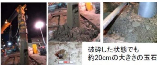
図-3 現地で大量の玉石が出ている地質状況
