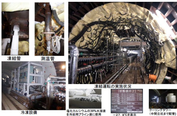
図-10 冷凍機運転しての凍結工法実施状況
