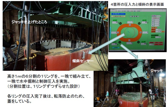
図-4 アーバンリング制御圧入の状況
