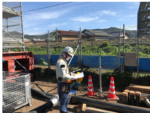
写真-3 工事管理者配置状況
