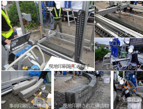
図-7 施工の様子
