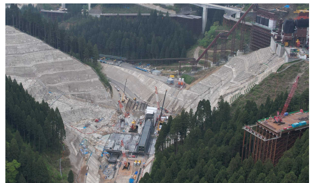
写真-1 ダム本体工事進捗状況写真（2023年4月時点）
