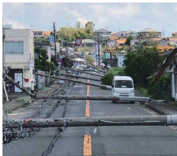
図-1 台風による電柱の倒壊
