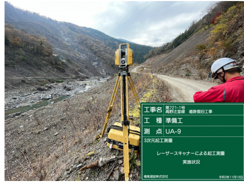
写真-2 TLSによる測量状況
