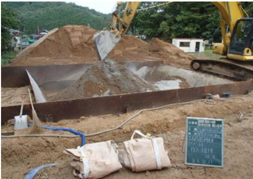
写真-2 攪拌作業
