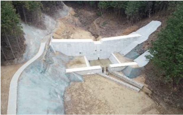
写真-1 大田川左支溪第3 砂防えん堤（INSEM工法）
