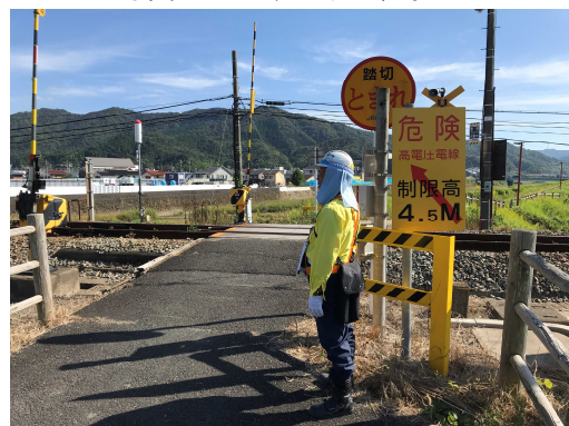
写真-4 列車見張り員配置状況
