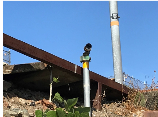
写真-2 プリズム設置状況
