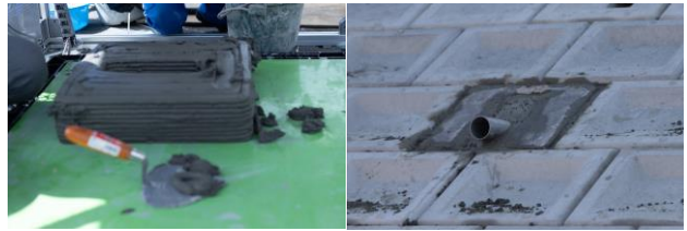
図-3 3Dプリンタで施工された法面ブロックの例
