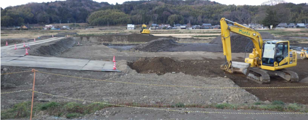
写真-4 スtockヤード造成状況
