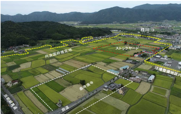
写真-1 千代川工区中央部付近
