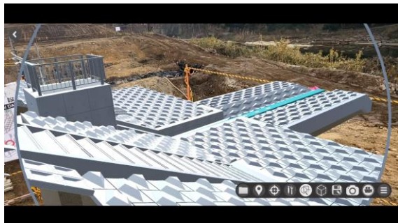
図-9 樋門施工箇所のAR映像
