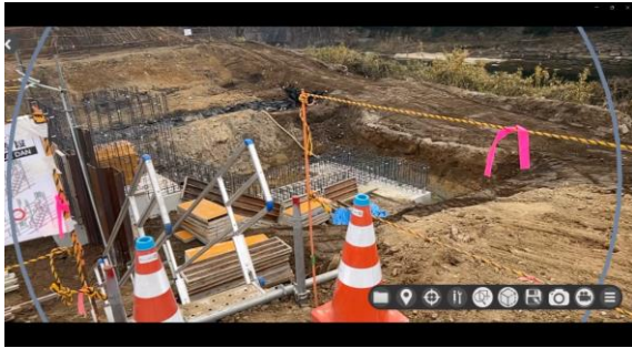
図-8 樋門施工箇所の実際の状況
