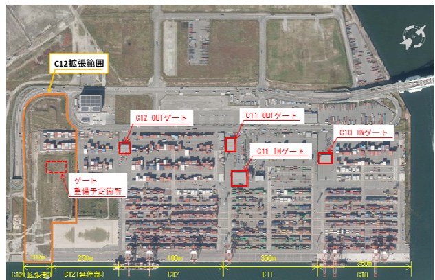
図-8 夢洲コンテナターミナル
