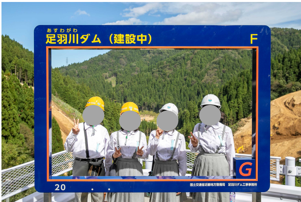
写真4 現場見学会のようす (基礎掘削状況の見学)
