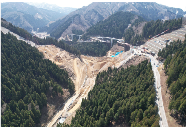
写真-1 基礎掘削状況写真 (2022年3月)
