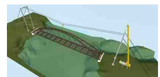
④補剛桁、横桁、縦桁の架設
