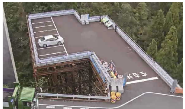
写真6 ダム本体建設工事展望台 (2022年11月)
