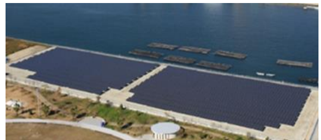
図-2 網干浜太陽光発電所
