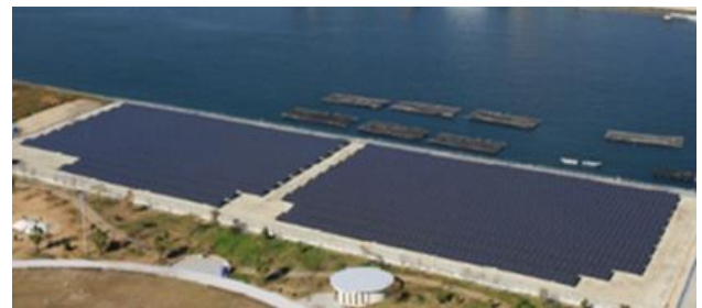
図-2 網干浜太陽光発電所
