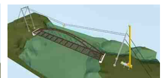
④補剛桁、横桁、縦桁の架設
