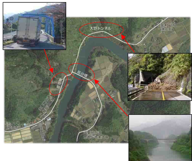
写真-3 現道の状況
