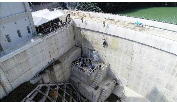
写真-10 横瀬川ダムクライミングウォール 3)
