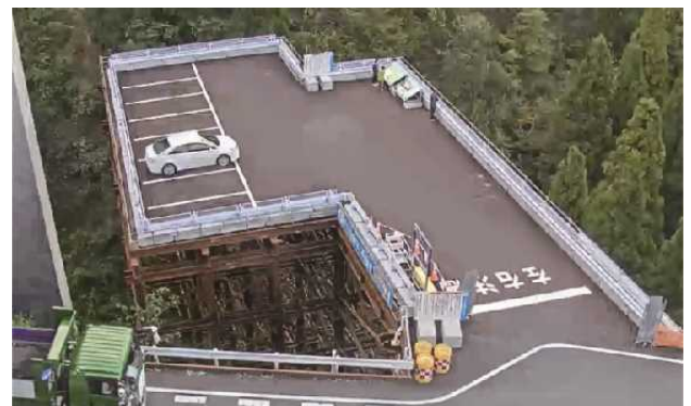
写真6 ダム本体建設工事展望台 (2022年11月)
