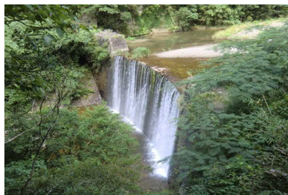
写真-1 左会津川砂防堰堤 (田辺市長野地内)
