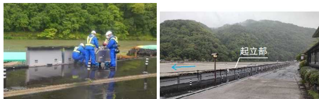
図-21 実操作の状況
