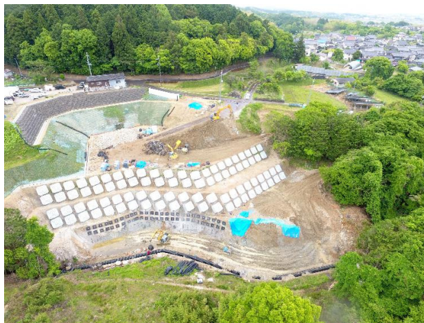
図-7 2022年4月末時点の現場状況
