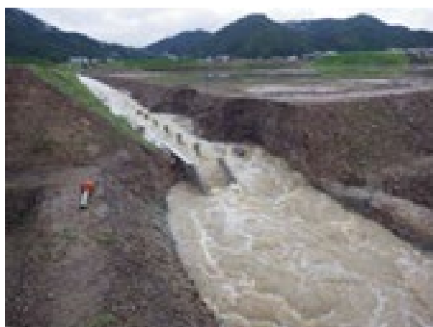
図-3 大雨時排水路状況
