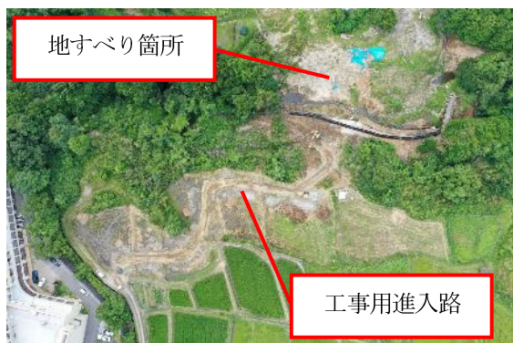
図-5 工事用進入路設置後
