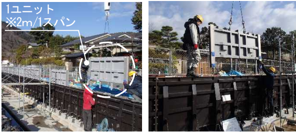
図-15 可動式止水壁の吊り込み状況
