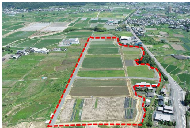
図-1 ほ場整備実施状況(左側工事未着手)
