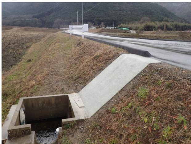
図-17 アスカーブ設置
