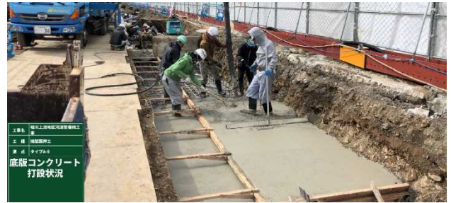
図-13 基礎構造の施工状況
