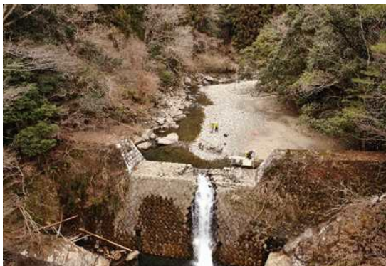
写真-2 和田川砂防堰堤 (田辺市下川上地内)
