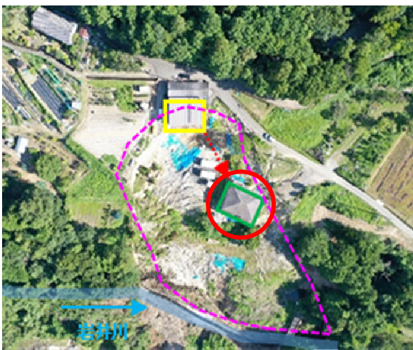
図-2 地すべり状況
