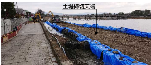
図-12 大型土のうによる土堤締切
