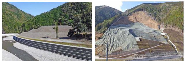
図-1 三越地区(平成30年3月整備完了) 図-2 清水地区(令和3年2月整備完了)
