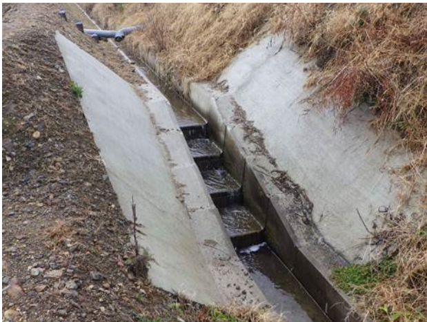
図-11 階段落差工張りコン設置
