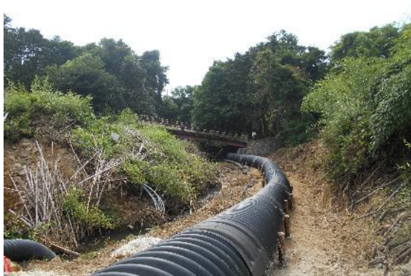
図-6 排水管設置後
