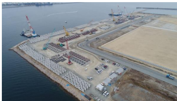
(c) 阪南二区 (岸和田市) 図-9 消波ブロック製作ヤード
