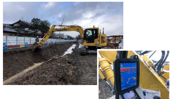
図-14 ICT建設機械による掘削状況
