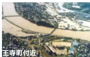
写真-1 昭和57年8月洪水による被害(奈良県王寺町)
