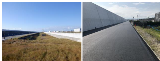
(c) 南側護岸嵩上げ後 (d) 北側護岸嵩上げ後
