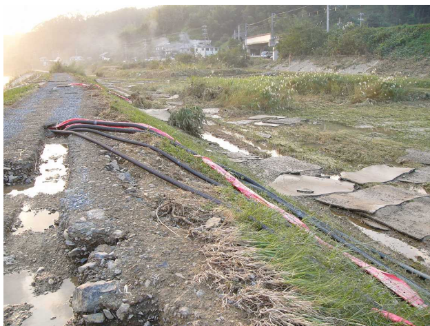
写真-1 大規模出水により剥出しになった管路
