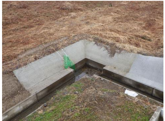
図-12 屈曲工張りコン設置
