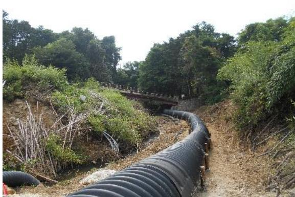
図-6 排水管設置後
