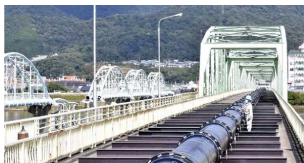
写真-1 六十谷橋への仮設配管敷設の様子
