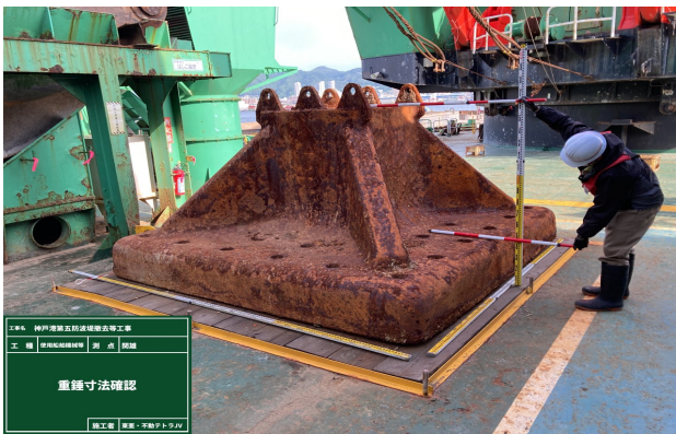
図6 押えに使用した35tの重錘
