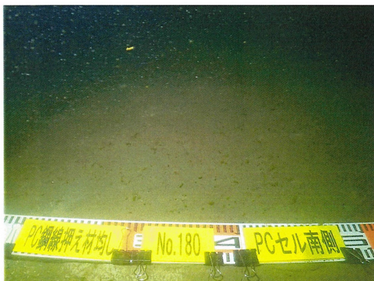
図14 PC鋼線押え材投入完了
