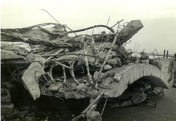
図4 被災したPC円筒セル
