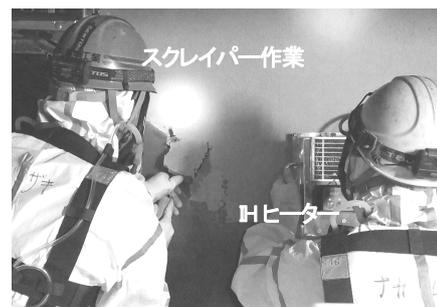
図-2 IHヒーターによる作業状況
