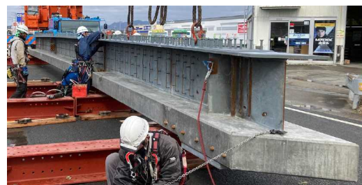
写真-8 地組作業
