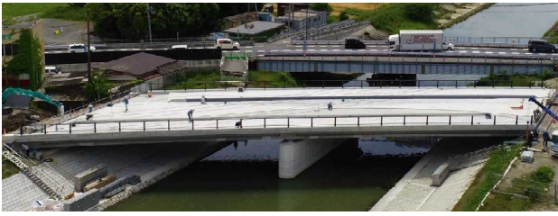
写真-15 国道9号若宮橋（桁高低くスリムな形状）ほぼ完成
