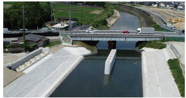
写真-3 下部工及び護岸の完成(手前)(奥が迂回路仮橋)
