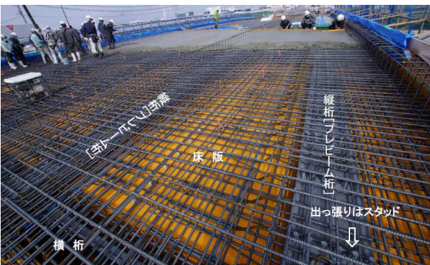
写真-11 床版横桁の配筋状況 (奥はコンクリート打設)
