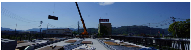
写真-13 応力開放 (リリース) 鉄板をクレーンで除荷
