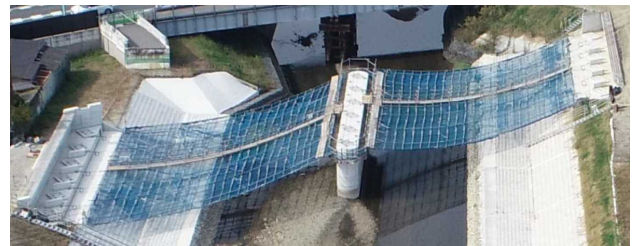
写真-7 ワイヤークーブル足場
