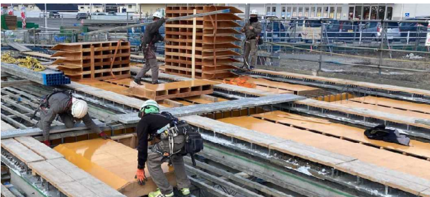
写真-10 床版の楕形状型枠 (工場製作) の設置
