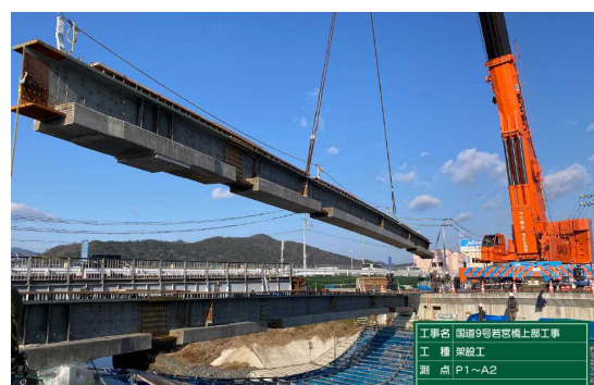
写真-9 プレビーム桁の架設 (2022年1月)
