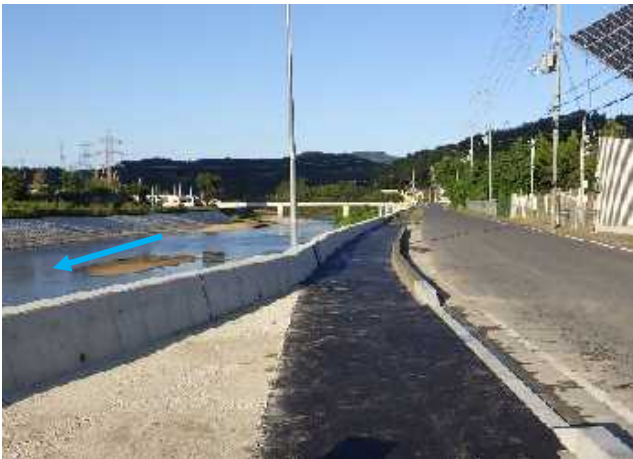
図5 パラペット護岸の参考写真
