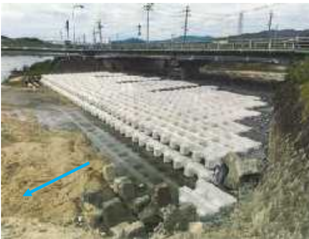
図-13 支川すりつけ工事完了写真
