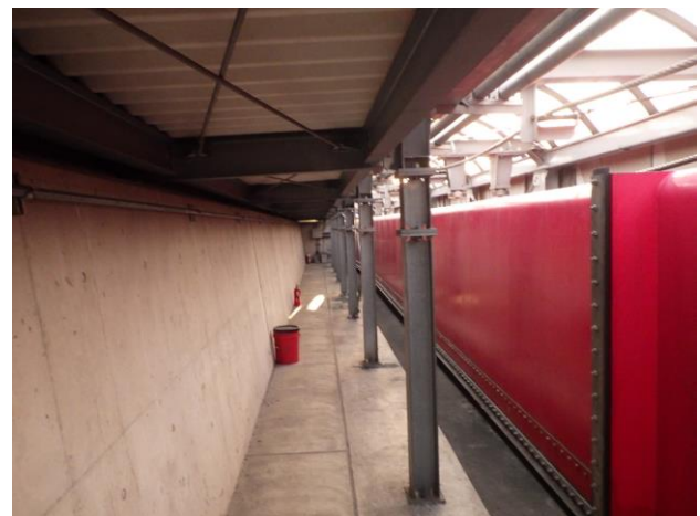
写真-3 陸閘格納庫内 状況写真
