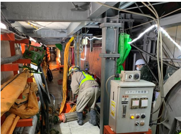
写真-7 施工状況
