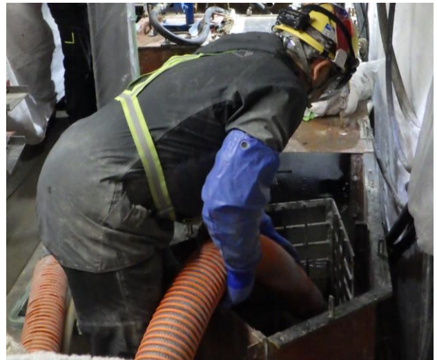
写真-9 排泥処理状況
