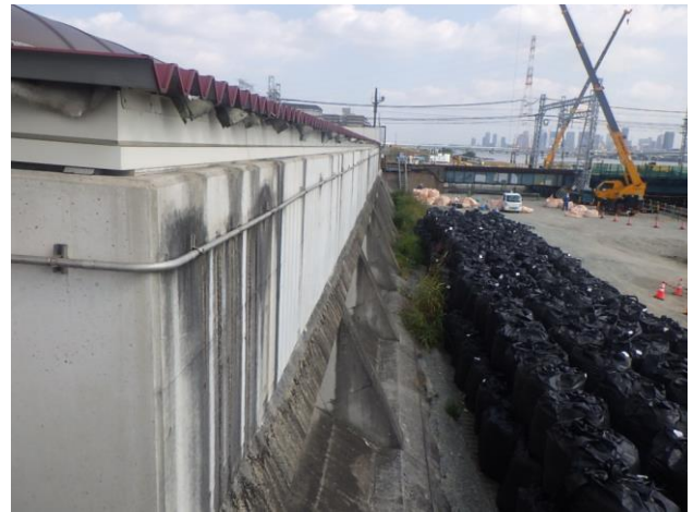
写真-2 陸閘格納庫外(河川側) 状況写真
