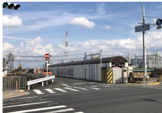
写真-1 伝法陸閘本体部(右岸側) 外観
