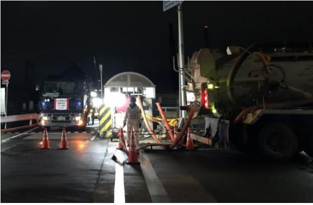
写真-10 バキューム車設置状況
