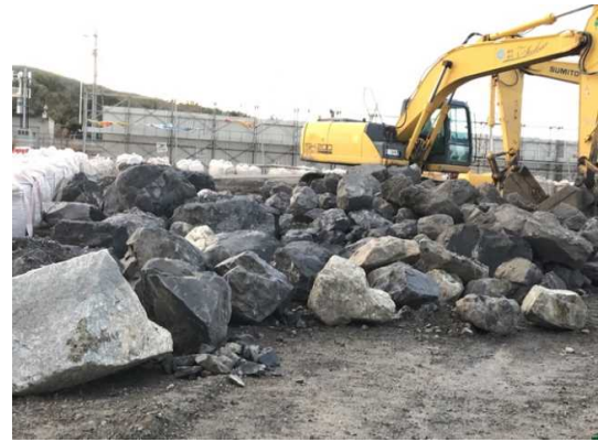
図-9 岩盤(硬質)の揚土状況
