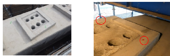
図-12 標定点設置状況
