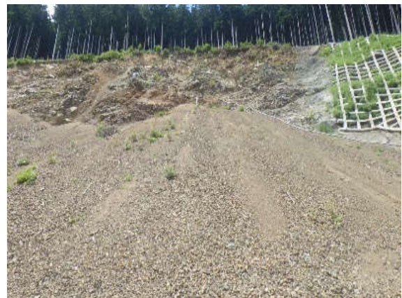
写真-1 施工前状況
