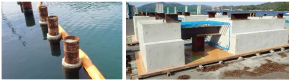
図-4 現地状況写真
