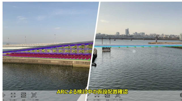
図-7 ARを用いた現場臨場 (仮設配置確認) (左：仮設スロープ、右：仮栈橋)
