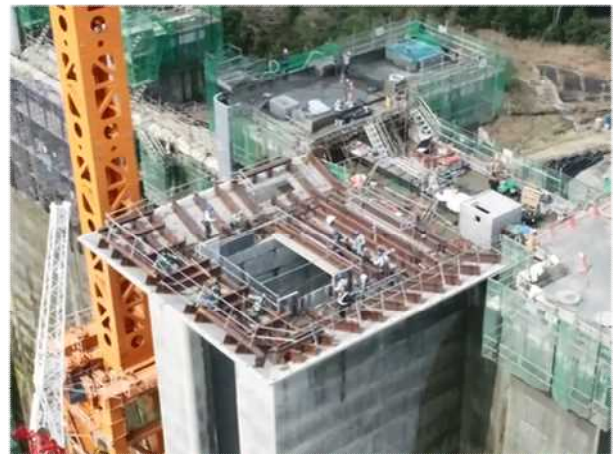
写真6 PCa型枠設置状況(取水設備)
