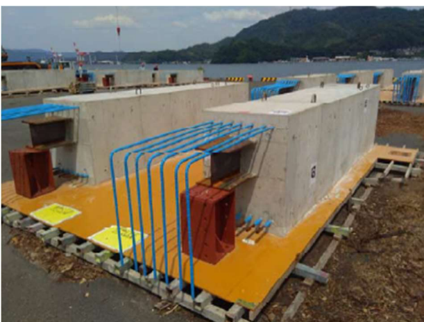
図- 16 点群データ収集対象物（梁 PCa ブロック）
