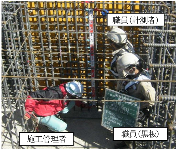
図-2 従来の鉄筋出来形計測作業で密になる様子
