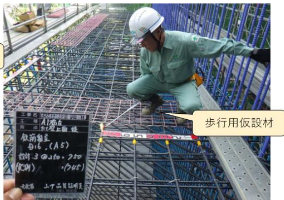
図-3 組み立てた鉄筋上での作業
