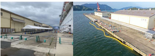
図-7 クルーズ船仮設屋根付き通路の設置状況
