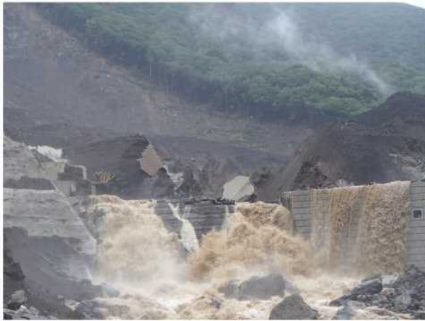
図-2 再崩落による赤谷2号砂防堰堤の損壊 (2014年8月)
