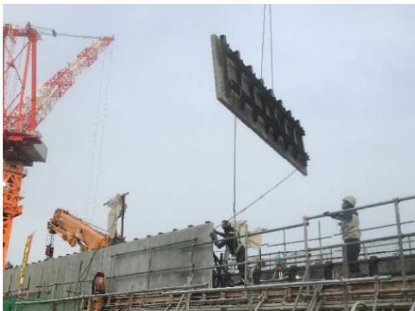
写真5 PCa 型枠設置状況(下流面勾配変化点)
