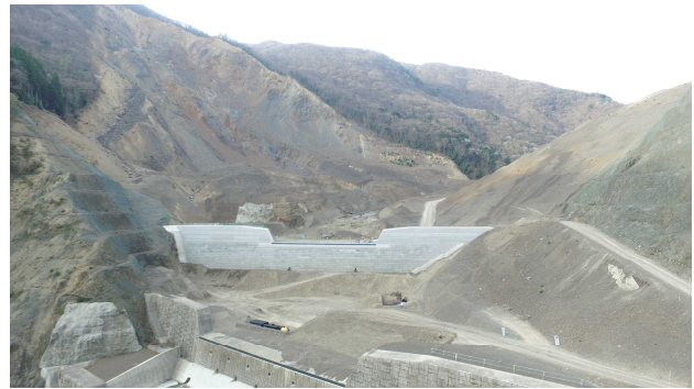
図-10 施工状況 (2022年4月時点)
