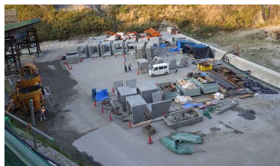
写真-2 PCa 部材ストックヤード
