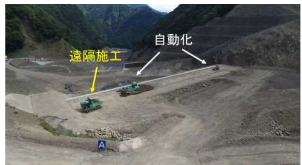
図-7 遠隔操作・自動化の施工風景
