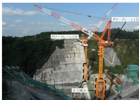
写真-3 タワークレーン運用状況
