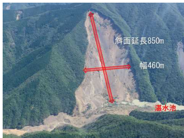
図-1 赤谷地区崩壊斜面
