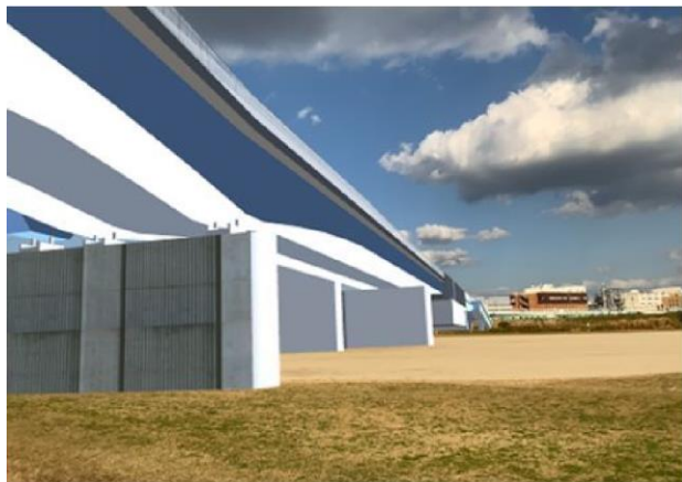
図-9 MR遠隔臨場（WEB動画へのCIMモデル合成）
