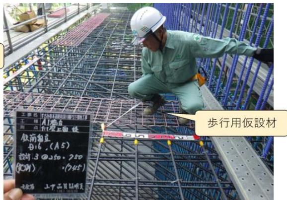
図-3 組み立てた鉄筋上での作業
