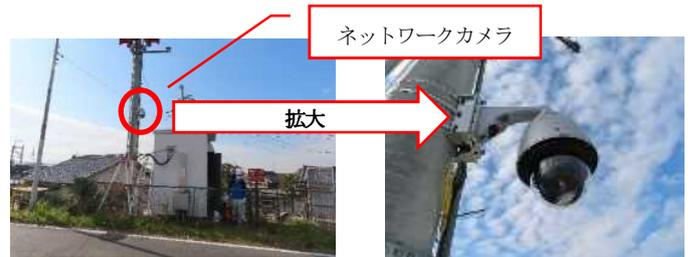
図-8 ネットワークカメラ設置状況(槇島)
