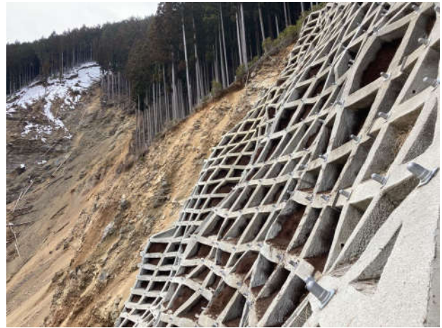
写真3 施工した法枠
