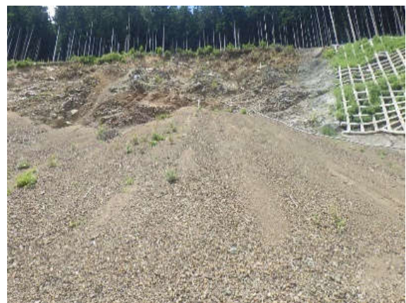
写真-1 施工前状況
