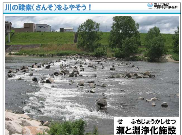
図9 瀬と淵浄化施設
