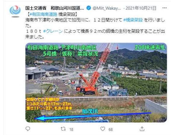
図-4 橋梁架設状況
