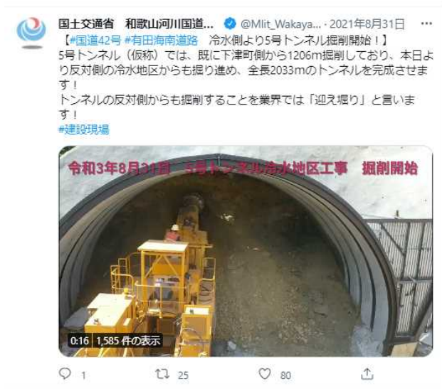
図-3 トンネル掘削状況
