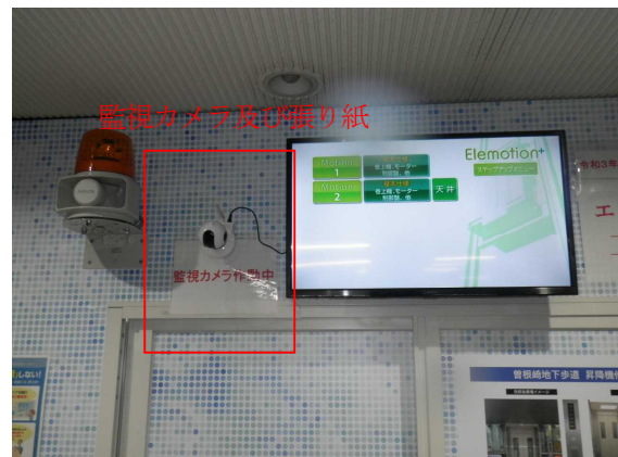
写真6 工事期間中の現場管理状況
