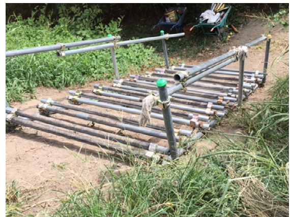
写真-1 堤体に設置された階段
