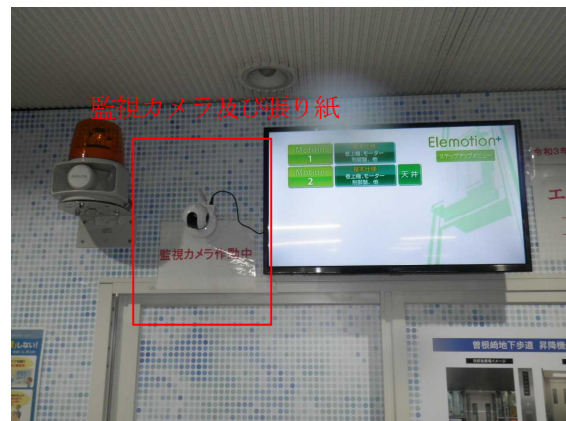
写真6 工事期間中の現場管理状況
