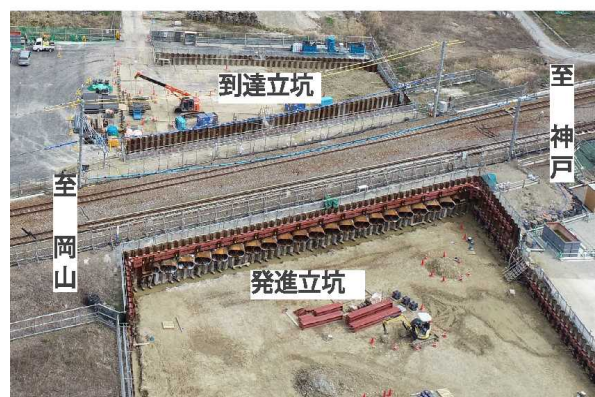
【写真-1 有年Bv工事 空撮写真 (2021.3.31時点)】
