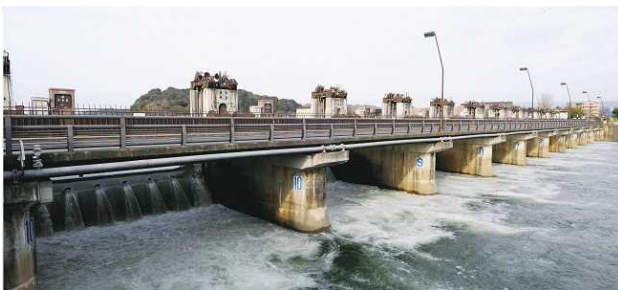
写真-1 瀬田川洗堰 本堰ゲート
