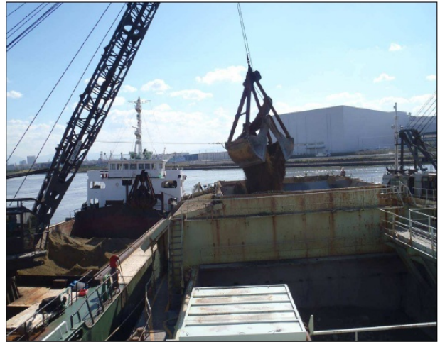
図-6 製鋼スラグと浚渫土砂の混合材投入状況
