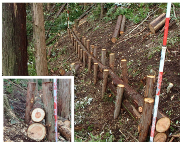
写真-5 挟込式丸太筋工 完成状況
