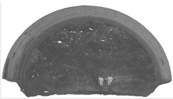
図-3 球面切羽全景 (大背先行上半先進ベンチカット工法) (2)現場流動覆工コンクリート施工について
