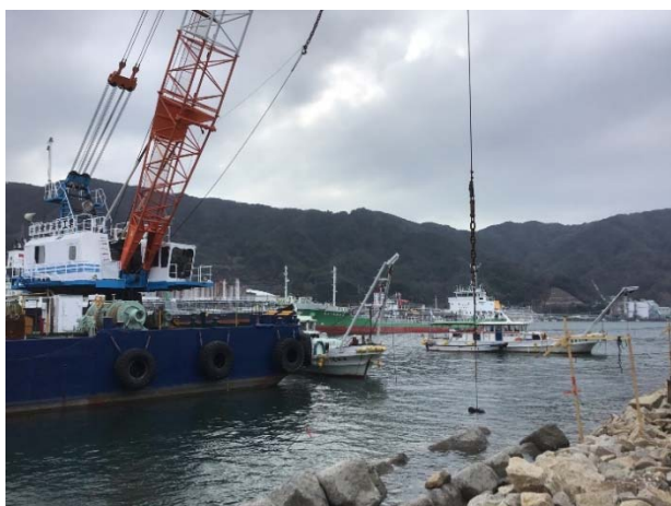
図-9 人工石据付状況
