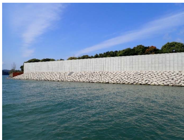
図-10 人工石据付完了状況
