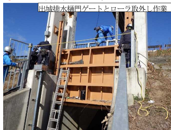
ローラ取り外して露出した軸
