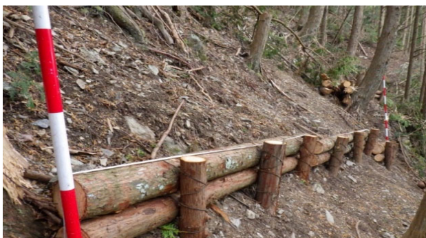
写真-1 従来型の丸太筋工
