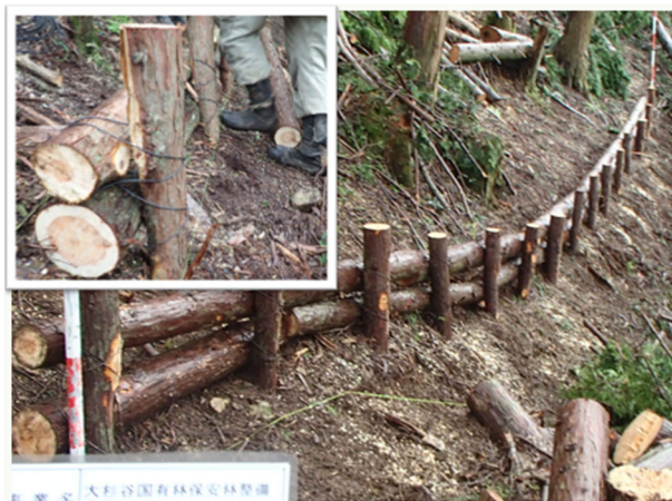
写真-4 鉄線緊結式丸太筋工 完成状況
