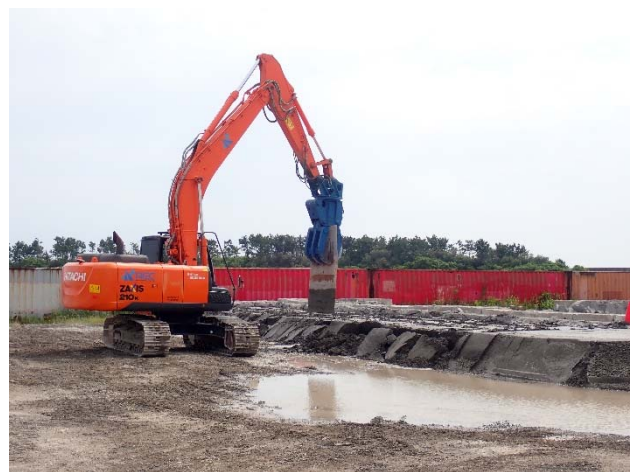
図5 人工石製作状況（条切り）
