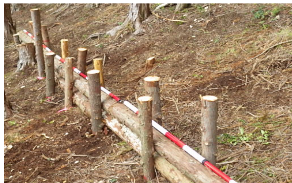
写真-3 試験施工完成状況
