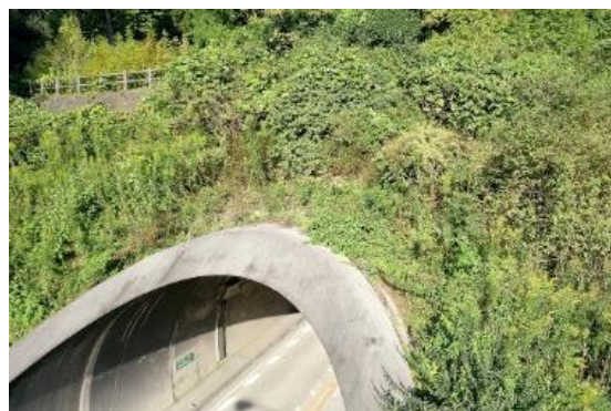
写真-2 国道 309 号 水越トンネル
