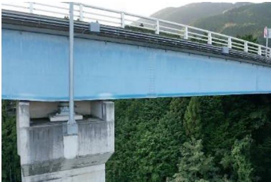
写真-4 国道 309号 関屋4号橋
