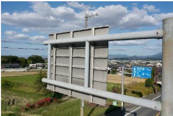
写真-5 国道 309号 大型標識
