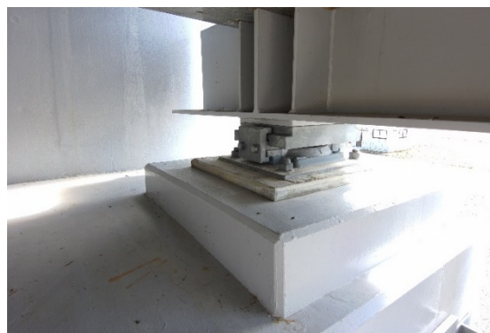
写真-2 支承撮影画像
