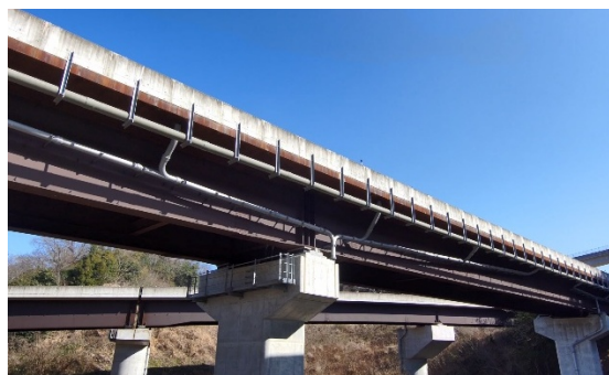
写真-1 橋梁側面写真
