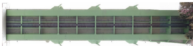
写真-4 桁下面合成画像
