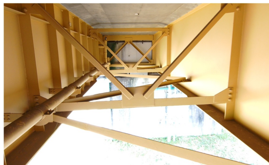
写真-3 桁間撮影画像
