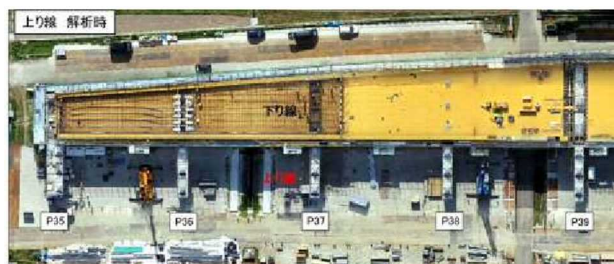
図5 オルソ画像：支承計測時 1)
