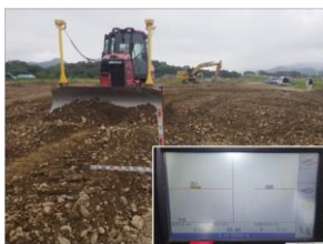
図-6 ICT土工 敷均し作業
