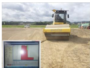
図-7 ICT土工 転圧作業
