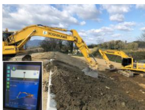
図-8 ICT土工 覆土法面整形作業
