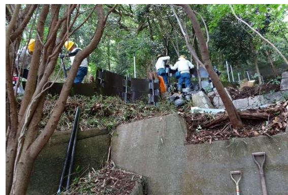
図-7 職員による土留鋼板施工
