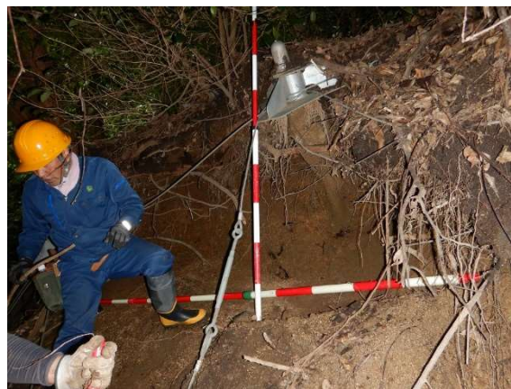
図-5 露出した鉄筋挿入工
