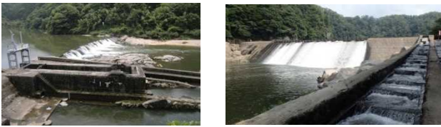
写真-3 堰全景(左:相楽発電所取水堰 右:大河原発電所取水堰)
