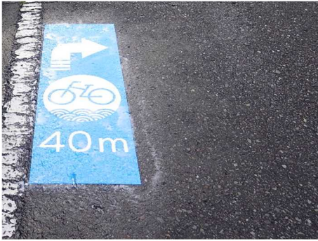
図-7 分岐部等での案内(路面標示(90箇所))
