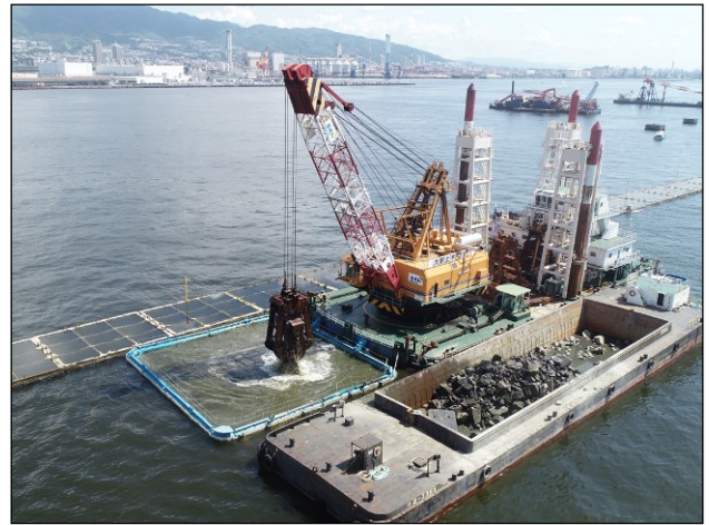
図4 神戸港第五防波堤撤去の様子
