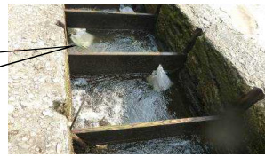
写真-7 大河原発電所取水堰魚道の試験的な改良
