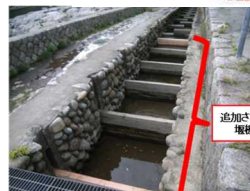
写真-6 相楽発電所取水堰魚道の改良状況
