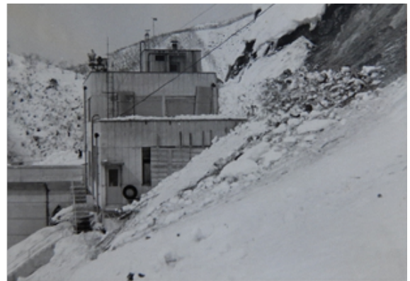
写真-1 なだれ状況
