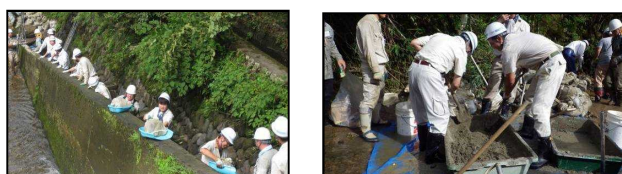
写真-15 作業風景 (左図：土嚢運搬、右図：土嚢作
