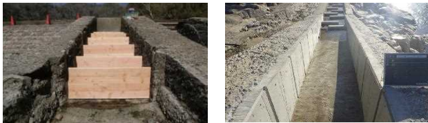
写真-8 施設管理者実施の魚道補修と改良(H31.2)
