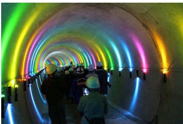
写真6 イベント時の仮排水トンネルライトアップ
