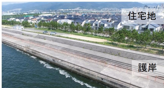
図-5 護岸周辺の状況
