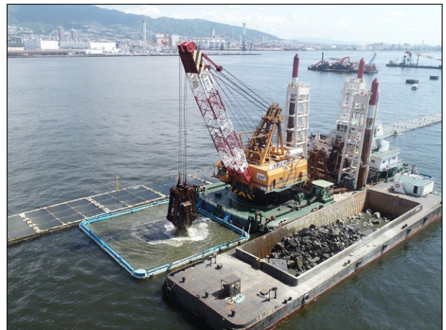
図4 神戸港第五防波堤撤去の様子
