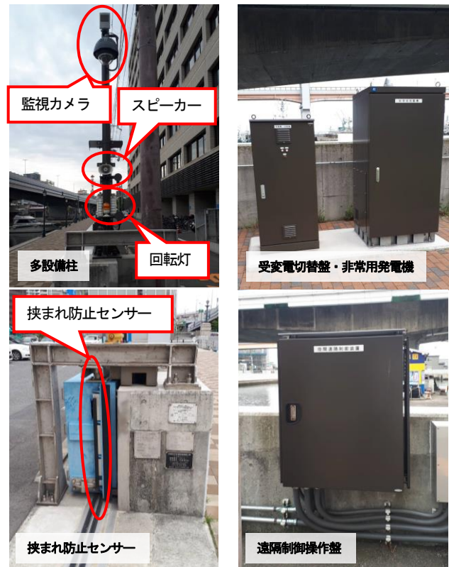
図-3 遠隔操作対象陸間及び周囲の各種機器
