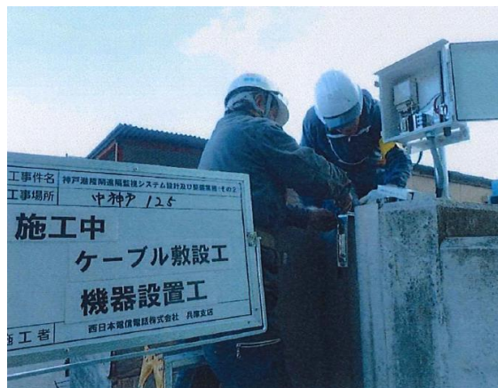
図-10 LoRaWAN™通信モジュールの設置例
