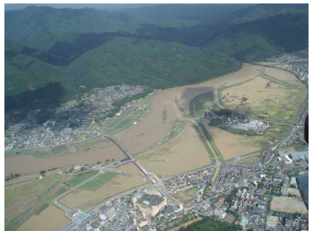
図-2 平成25年台風第18号の影響による溢水した桂川
