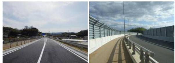
写真-11 排水性舗装と目隠しフェンス
