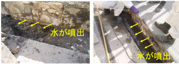
(a)敷モルタル撤去時1 (b)敷モルタル撤去時2
