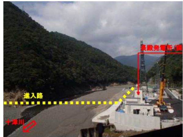
図-4 発電所渡河仮橋案のイメージ
