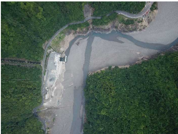
写真-2 上空からみた河川内の土砂堆積状況
