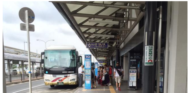
写真-3 ターミナルビル前の歩道（南側・大規模改修前）
