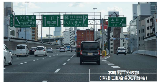
図-2 予告標識と分岐部標識の併設による煩雑な分岐案内（本町出口分岐部付近）
