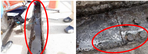
写-3 歩車道境界の縁石撤去
