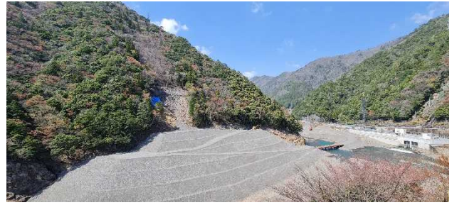
写真-4 工事用道路【パターン①】の完成写真
