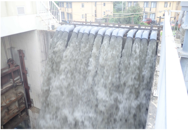
図-9 排水機能確保のための仮設ポンプ確認運転
