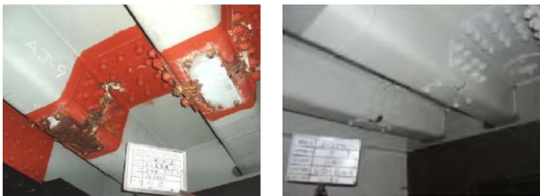
写-8,9 H20定期点検(左) H26定期点検(右)
