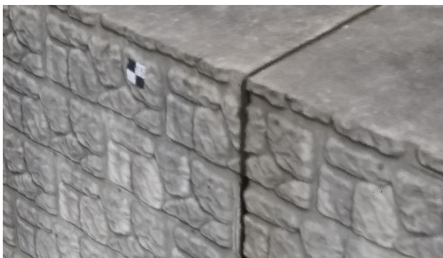
図-9 直壁の点群データ (拡大)
