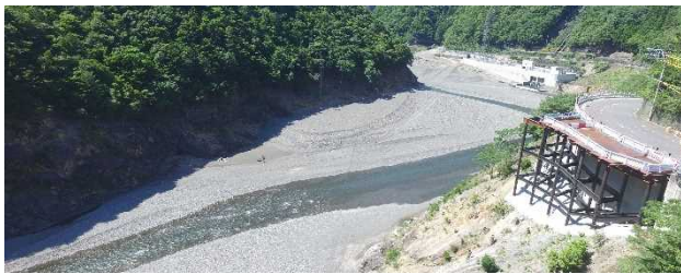
写真-1 工事着手した1号橋取付道路
