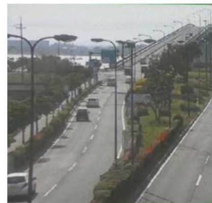
写真-2 西詰道路状況 (ETC導入後2019.6.18 AM8:00)
