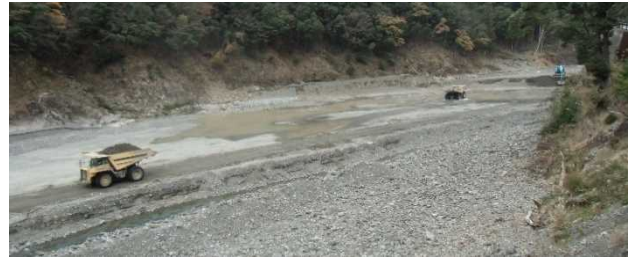
写真-3 河川内の土砂の運搬作業
