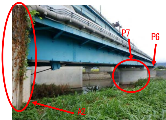
写-1 下り7, 8径間全景
