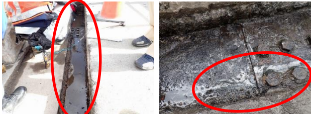
写-3 歩車道境界の縁石撤去
