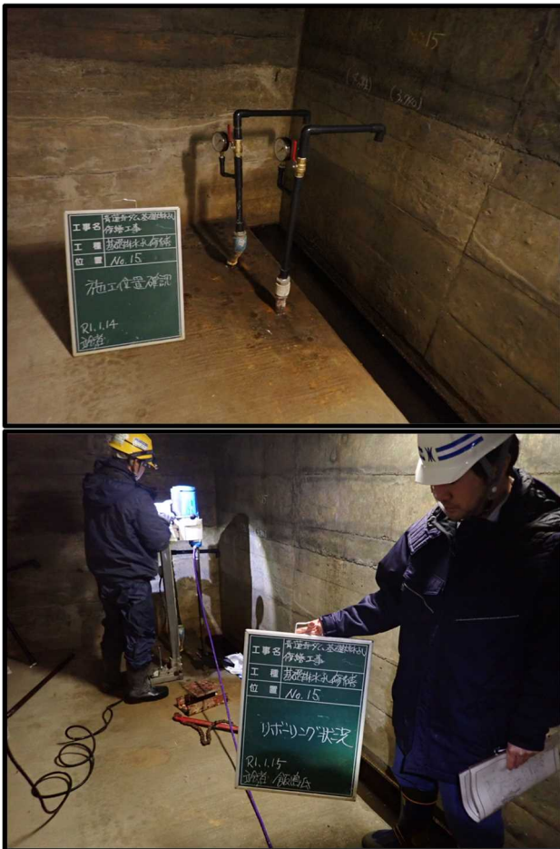
図4 リボーリングの状況 (No.15)
