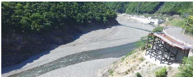
写真-1 工事着手した1号橋取付道路
