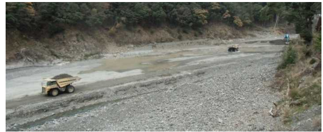
写真-3 河川内の土砂の運搬作業
